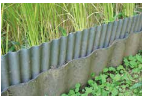
溝の崩れ防止のため、水田などでよく使われているあぜ波シートを使うと便利。
