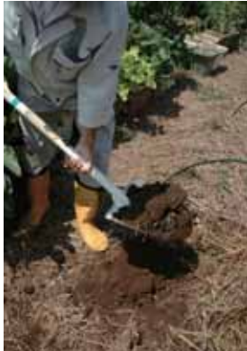
土をすくい上げる。
