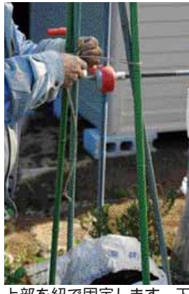
上部を紐で固定します。下部はブロックなどでかためましょう。
